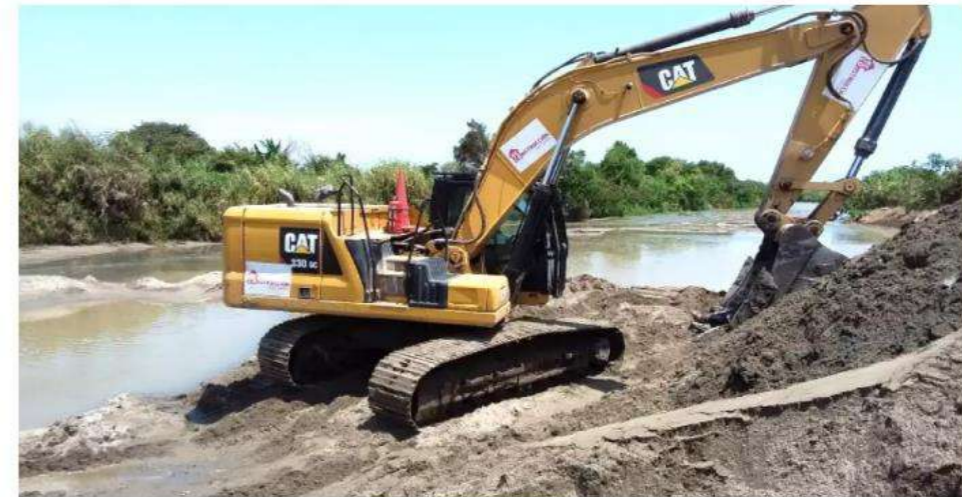
Realizan limpieza y descolmatación en río Lacramarca de Chimbote (Foto: Exitosa Chimbote)
