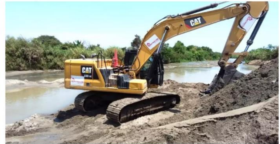
Realizan limpieza y descolmatación en río Lacramarca de Chimbote (Foto: Exitosa Chimbote)
